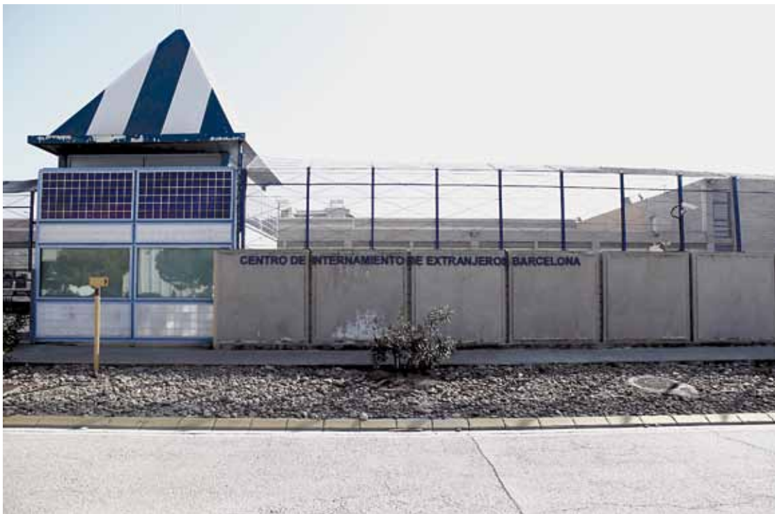
Aspecte exterior del CIE de la Zona Franca, que porta 6 anys en funcionament
